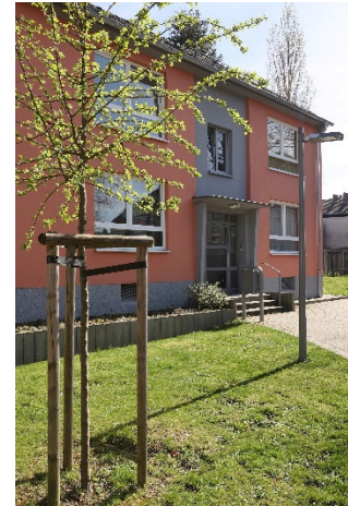
Siedlung Messerstraße: Beschaulich und günstig
