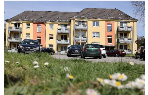
Siedlung Glockenstraße: schön dank Modernisierung
