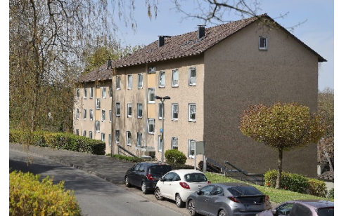
Siedlung Brühler Berg: Gepflegte Wohnungen zum günstigen Preis
